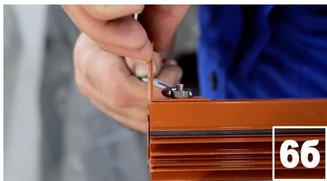
7. Установите нижние угловые стойки на углы основания срезами вовнутрь по ширине теплицы и закрепите их с помощью заранее установленных болтов М6х12 (7а, 7б).
