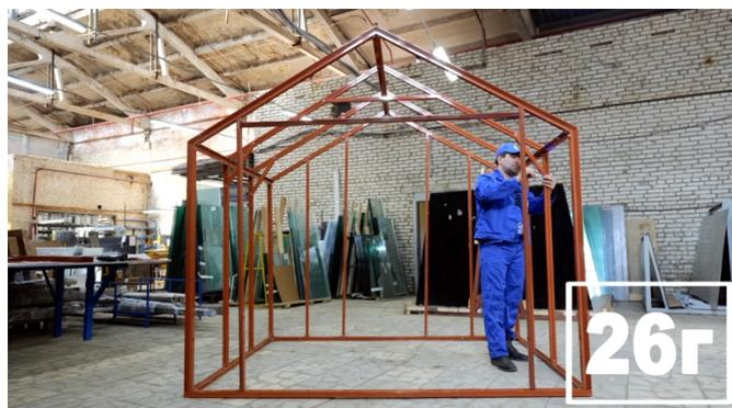
27. Установите и закрепите торцевые и боковые распорки по углам теплицы на заранее вставленные болты. Большие распорки по ширине теплицы, малые – в торцах. Распорки крепятся малым вырубом к основанию и большим – к нижним угловым стойкам (27а – 27г).
