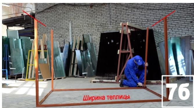
8. Установите болты М6х12 в внутренний паз угловых стоек по стороне ширины теплицы и временно закрепите их ниже верхнего края на 15-20 см гайкой М6 через шайбу (8а, 8б).
