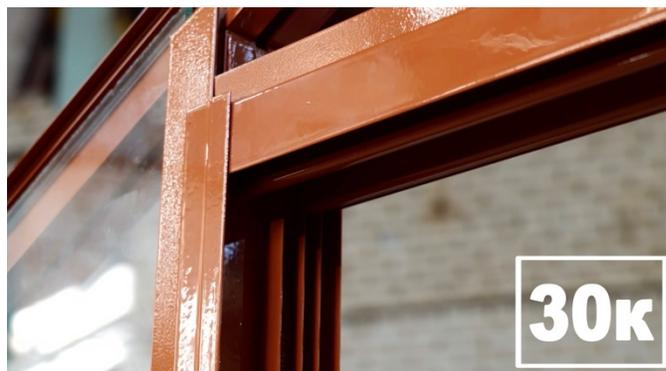
31. Установите верхние торцевые стекла над дверным проемом, заведя их внизу и сбоку под прижимные планки (31а – 31в). Установите верхние торцевые стойки, соединив их с L-образной и T-образной пластинами при помощи болтов (31г, 31д). Установите верхние торцевые стойки на место, совместив их со стеклом и затяните болтовые соединения на пластинах (31е – 31к).
