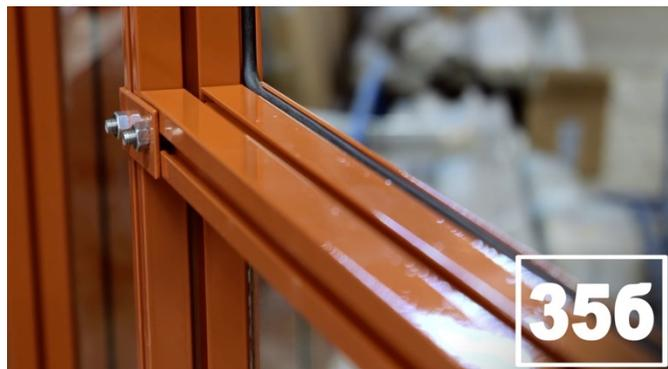
36. Приложите держатель торцевой форточки к прижимной планке торцевой перемычки и отметьте маркером отверстия точно по центру планки (36а). Просверлите отверстия в планке (36б) и закрепите держатель к торцевой перемычке через планку с помощью саморезов (36в, 36г). Закрепите торцевую форточку к держателю с помощью шпильки и наклейте резиновый D-образный уплотнитель изнутри по периметру форточки (36д – 36к).
